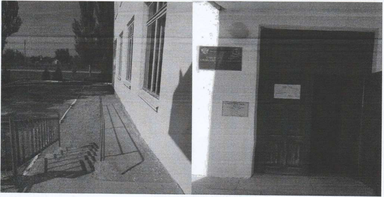
Вход в здание, фото № 4-6
